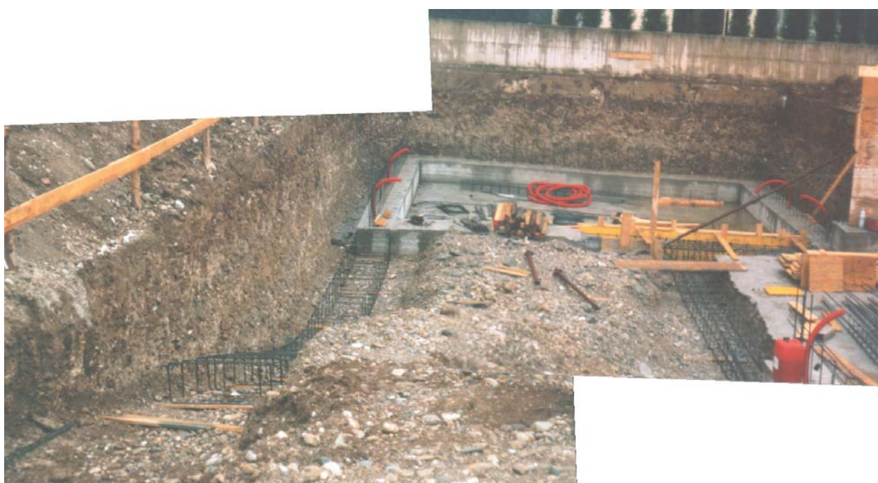
Foto n.11 Panoramica dei terreni presenti nello scavo n. 6
