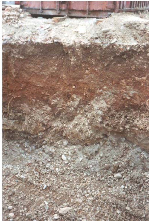
Foto n. 12 Panoramica dei terreni presenti nello scavo n. 7
