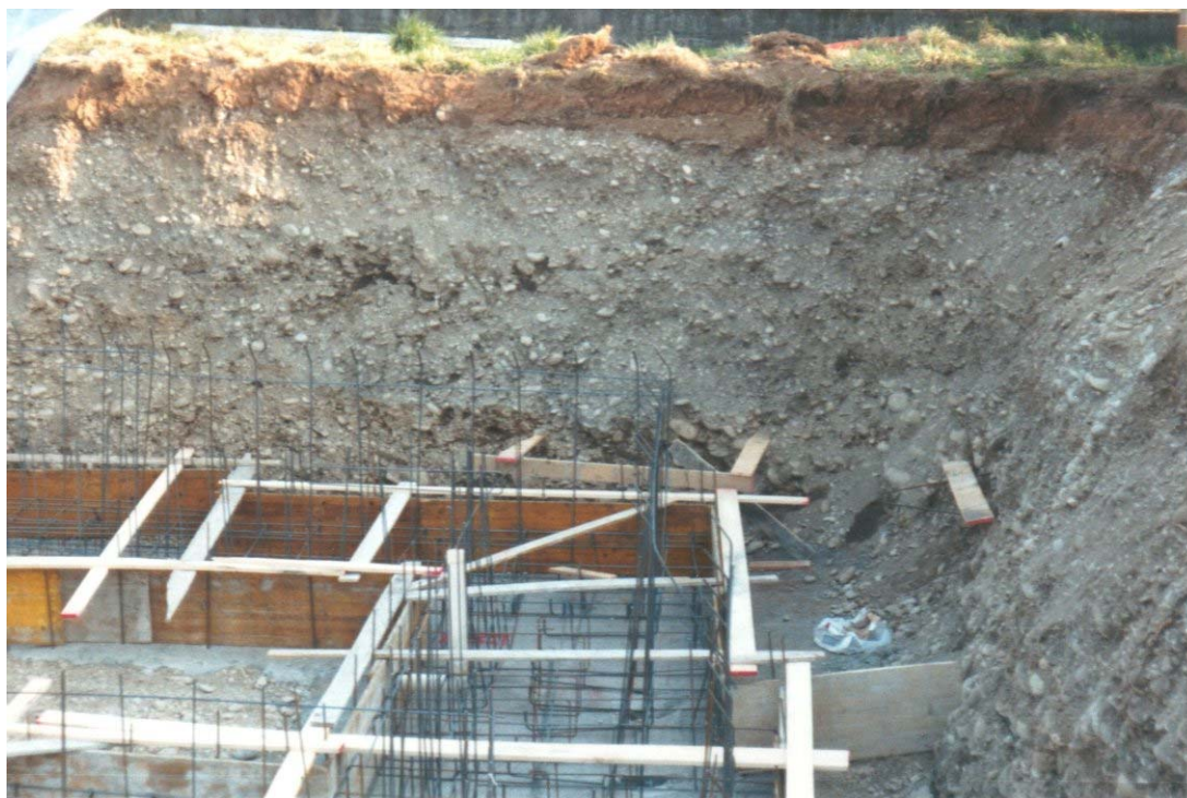
Foto n. 14 Panoramica dei terreni presenti nello scavo n. 2
