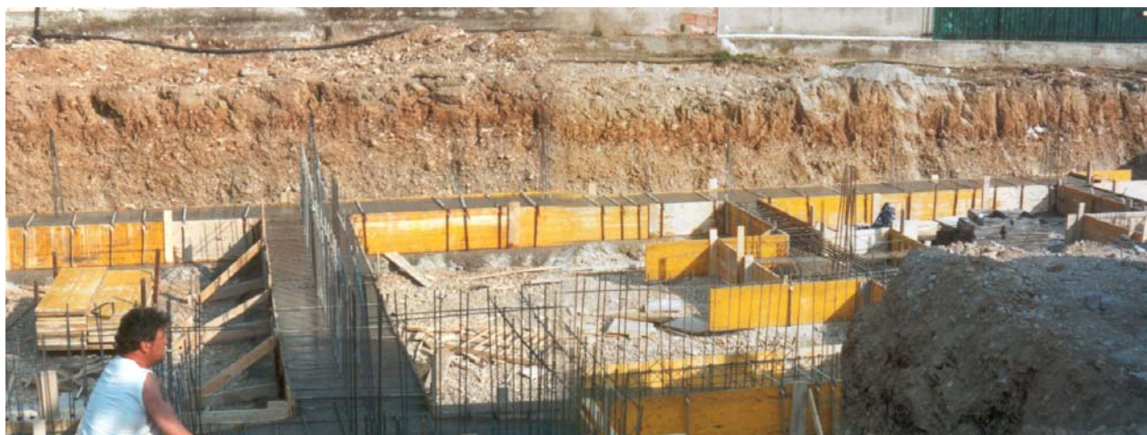
Foto n.10 Panoramica dei terreni presenti nello scavo n. 5
